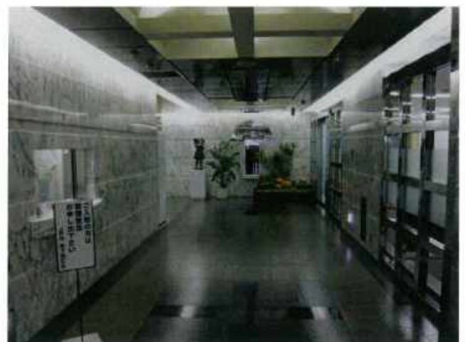
(改修前) エントランスホール
